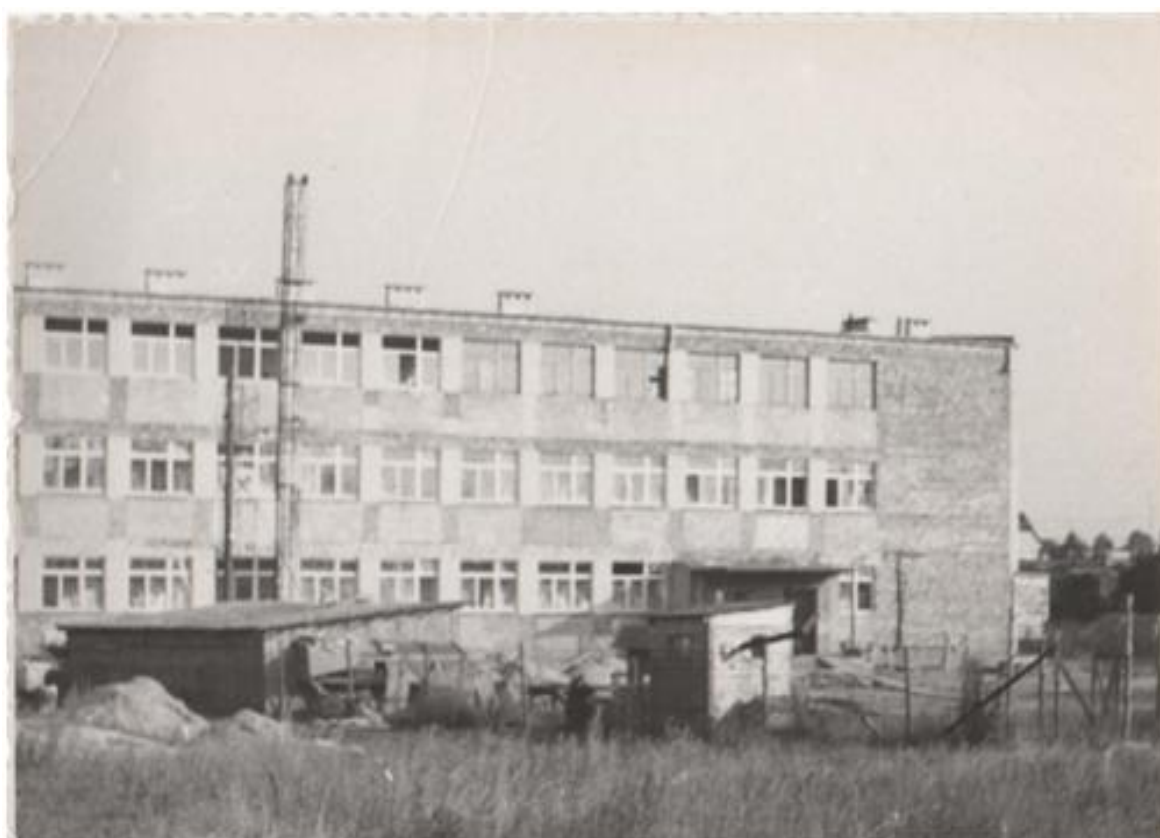
Fot. Budynek nowej szkoły podstawowej w Goworowie w trakcie budowy (arch. SP w Goworowie).
